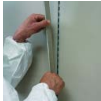
Fase 5 Distacco protezione Phase 5 Detachment protection
