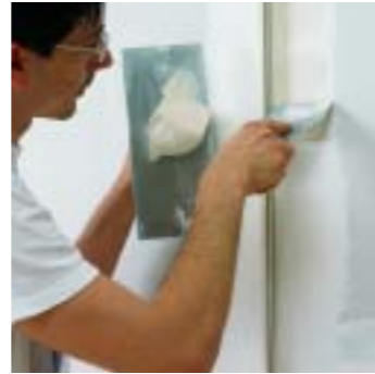
Fase 3 Stuccatura con protezione profilo Phase 3 Surfacing with outline protection
